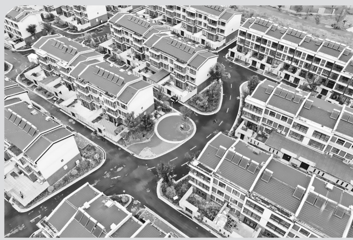
位于洪泽湖畔的江苏省泗洪县临淮镇胜利社区是渔民集中搬迁上岸后形成的新型农村社区。过去的胜利村整村在湖面上生产生活,是名副其实的“水上村”。2019年6月该村整体“生态搬迁”,渔民们告别了多年的“水上漂”生活。 新华社记者 季春鹏摄
