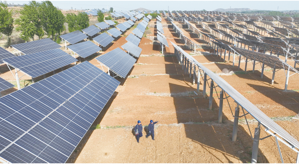
近年来,河北省石家庄市加快清洁能源开发利用,有序推动风电、光伏发电和生物质发电等新能源项目建设,助力绿色低碳发展。据国网石家庄供电公司介绍,目前该市风电、光伏发电和生物质发电等清洁能源装机容量达740万千瓦,约占统调电源总装机容量的43.22%。图为4月16日,工人在灵寿县谭庄乡程家庄村的光伏发电场巡查(无人机照片)。 新华社记者 杨世尧摄
