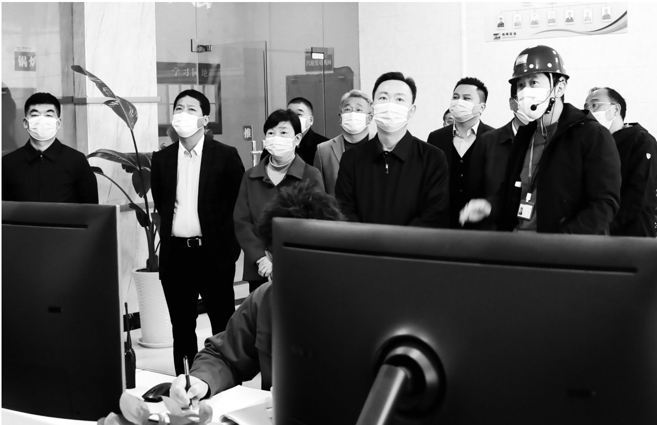
近日,安徽省阜阳市人大常委会组织调研组,深入界首市开展关于2021年全市环境状况和环境保护目标完成情况调研。图为调研组在界首市生活垃圾焚烧发电项目现场察看。
