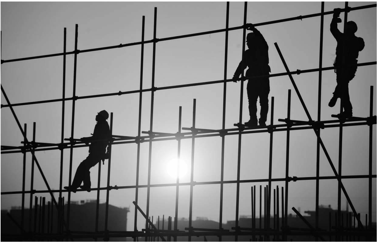
在河北雄安新区容西安置房项目 D 标段施工现场，中铁上海工程局工人在忙碌地工作。
