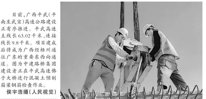
目前,广西平武(平南至武宣)高速公路建设正有序推进。平武高速主线长63.02千米,连接线长9.8千米。项目建成后将成为广西经梧州通往广东的重要东西向通道。因为中建路桥集团建设者正在平武高速佛子大桥进行混凝土预制箱梁钢筋检查作业。侯宇浩摄(人民视觉)
