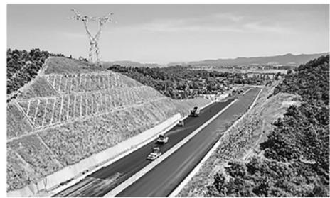
位于江西省吉安市吉水县的105国道吉水段改建工程全长约25千米,按双向四车道一级公路标准进行东移改造,总投资12.04亿元,预计今年年底建成通车。图为7月12日,工程施工人员正浇筑沥青路面。廖敏摄(人民视觉)
