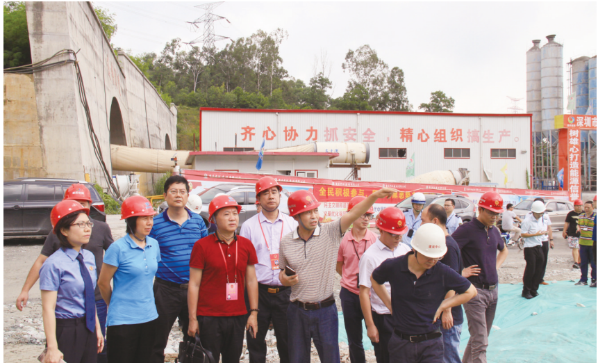
深圳市、罗湖区人大代表在东部过境高速公路项目现场视察。
