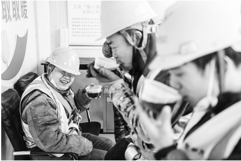
12月12日,在位于北京市海淀区的一处工地上,工人在喝姜茶驱寒。
