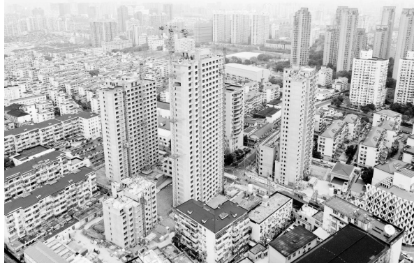
上海市静安区谈家桥城市更新项目建设工地(无人机照片) 新华社记者 方喆摄
