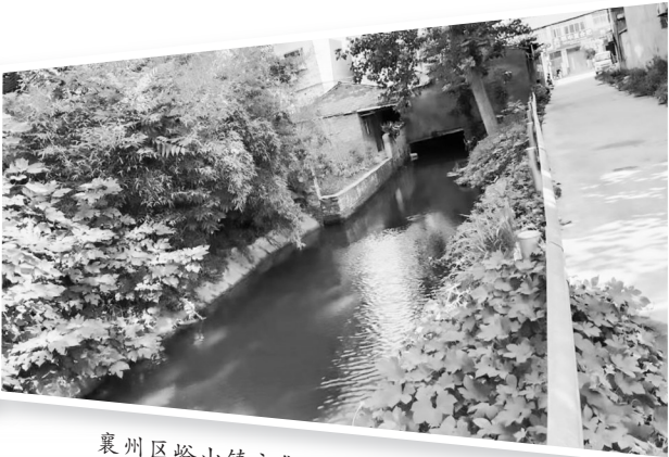
襄州区峪山镇方集社区堰塘污染整治后现状
