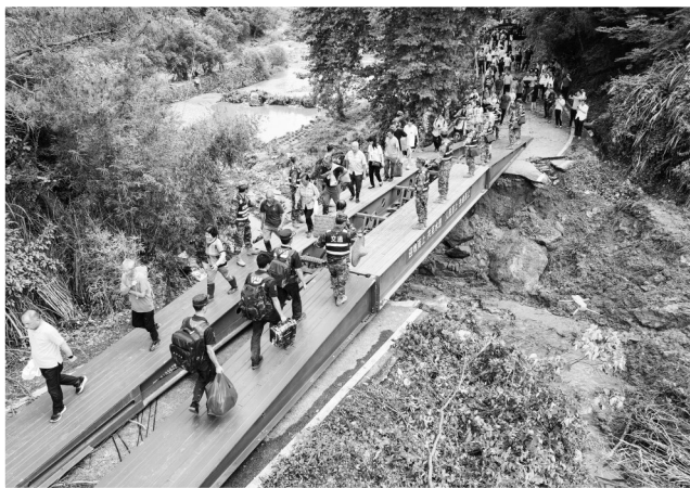
6月22日,在安徽省黄山市歙县绍濂乡小溪村,武警官兵架设的临时桥梁贯通,村民通过桥梁出行(无人机照片)。
