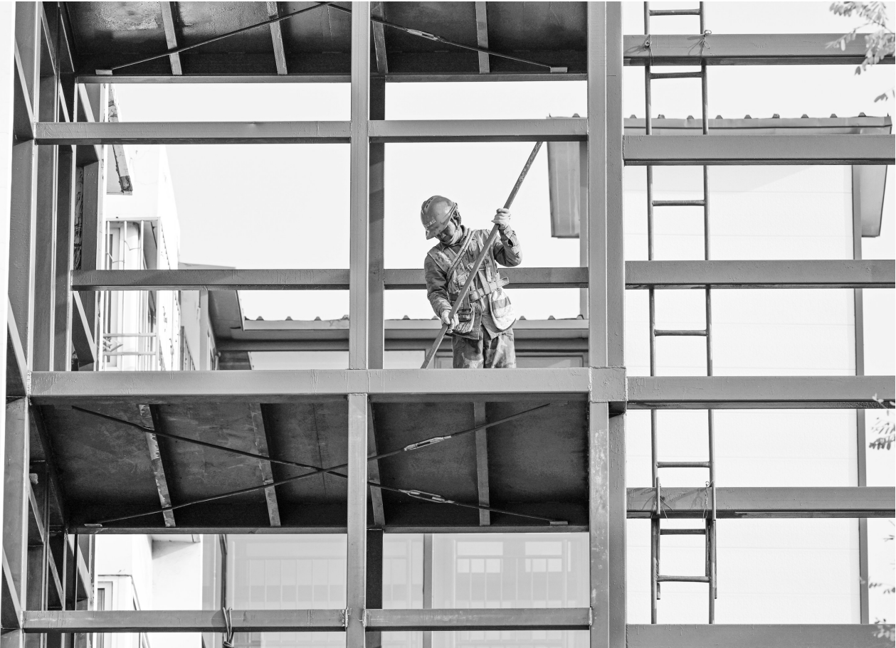
近年来，宁夏银川市兴庆区有序推进城市更新，将“民生小事”作为“头等大事”来办，结合老旧小区改造，完善“一老一小”服务设施，着力推动老旧小区加装电梯等民生实事，不断提升群众居住幸福指数。图为10月31日，工人在银川市兴庆区燕和园小区加装电梯。
