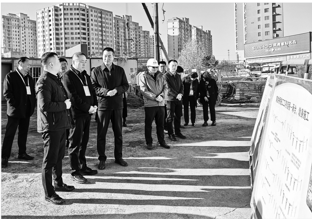
近日,河南省新郑市人大常委会对2025年重点民生实事办理情况进行视察。图为视察组在南关桥新建工程项目现场听取项目负责人汇报相关情况。 曹永强摄
