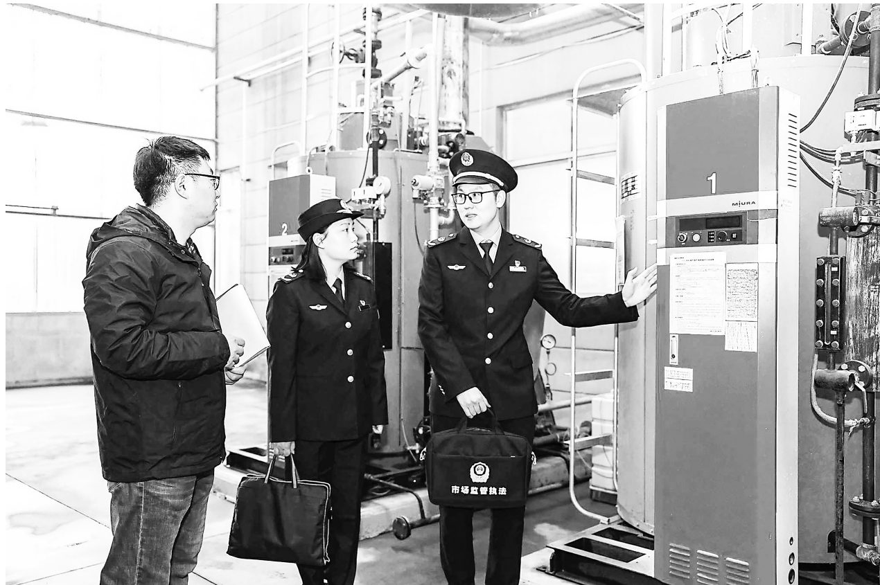
近日,江苏省常州市武进区市场监管局针对辖区企业开展了一系列特种设备安全管理提升助企活动。图为该区高新区分局执法人员对辖区企业的立式锅炉进行检查。袁继飞摄
